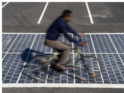
La route photovoltaïque de Colas a été récompensée
